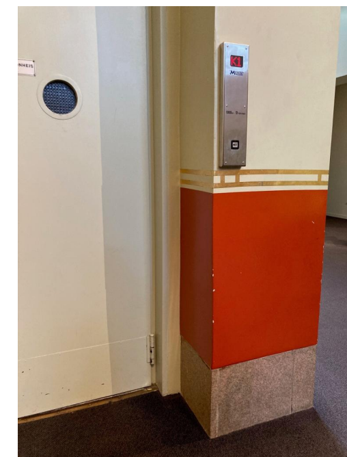
Betjeningsknappen må senkes i forhold til dagens heis for å tilfredsstille krav til universell utforming.
