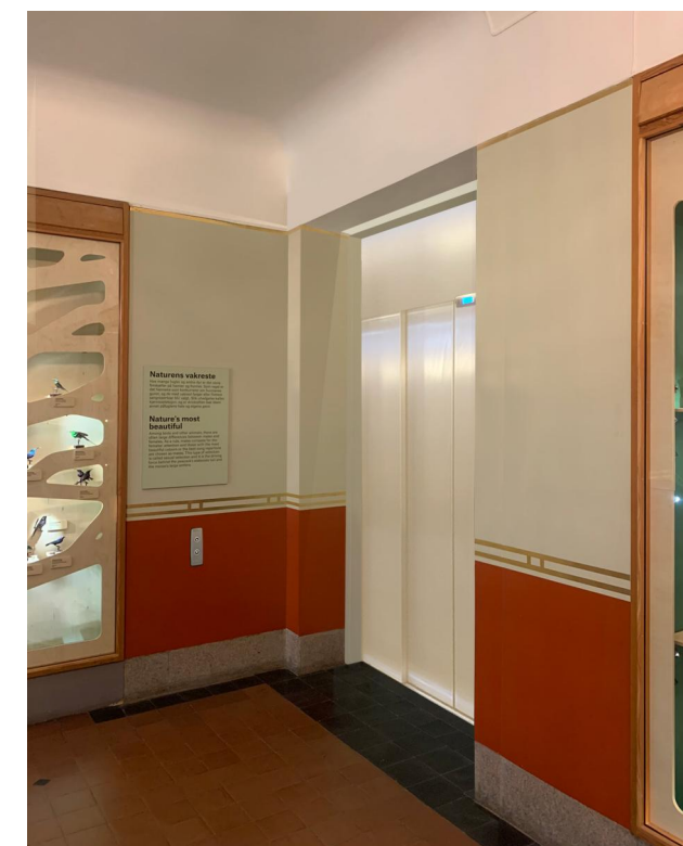
Foreslått løsning med ny heisfront med lavere dører med blindfelt over, tilbakeført nisje, flyttet betjeningspanel og ny innfelt belysning.
